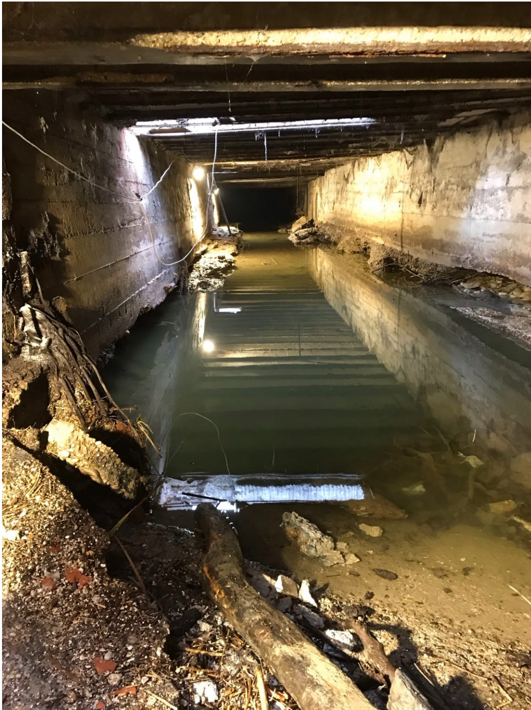
Figura 4 particolare dell'erosione alla base dei muri di sponda della Roggia Musonello
