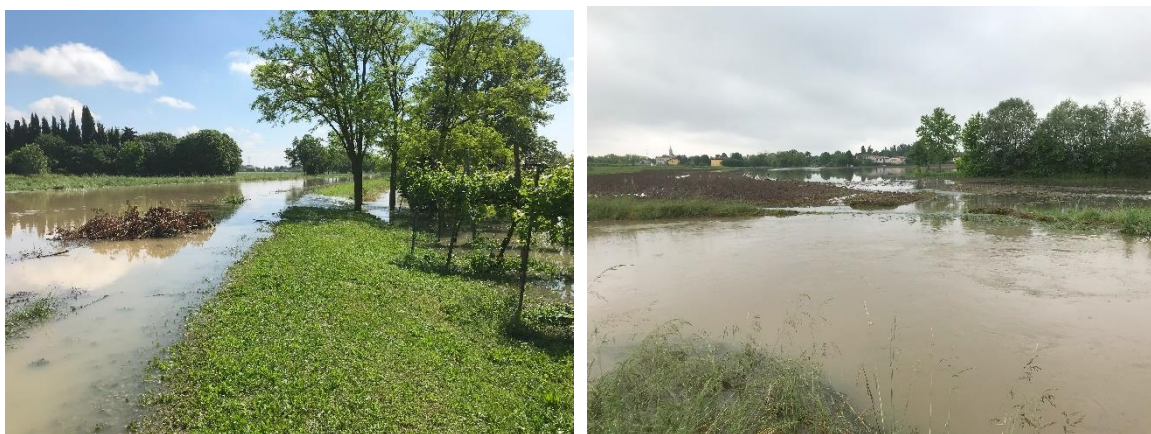
Figura 1 Tracimazione a seguito degli avvallamenti/cedimenti arginali del Canale Correggio – Figura 2 Tracimazione a seguito degli avvallamenti/cedimenti arginali del Fiume Meolo
